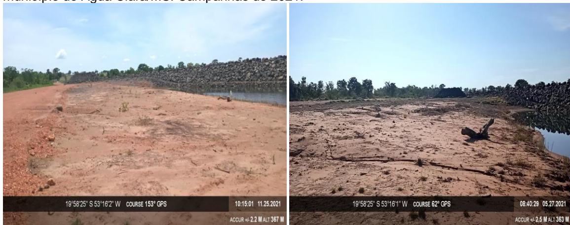
Figura 7 – Ponto 5: Erosão laminar na margem esquerda do reservatório, área 1 da PCH Verde 4, município de Água Clara/MS. Campanhas de 2021.
