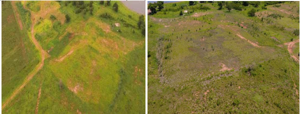
Figura 3 – Imagem aérea da área antigamente ocupada pelas estruturas da rampa de lavagem e oficina e posto de combustível. Maio de 2021 (à esquerda) e novembro de 2021 (à direita).
