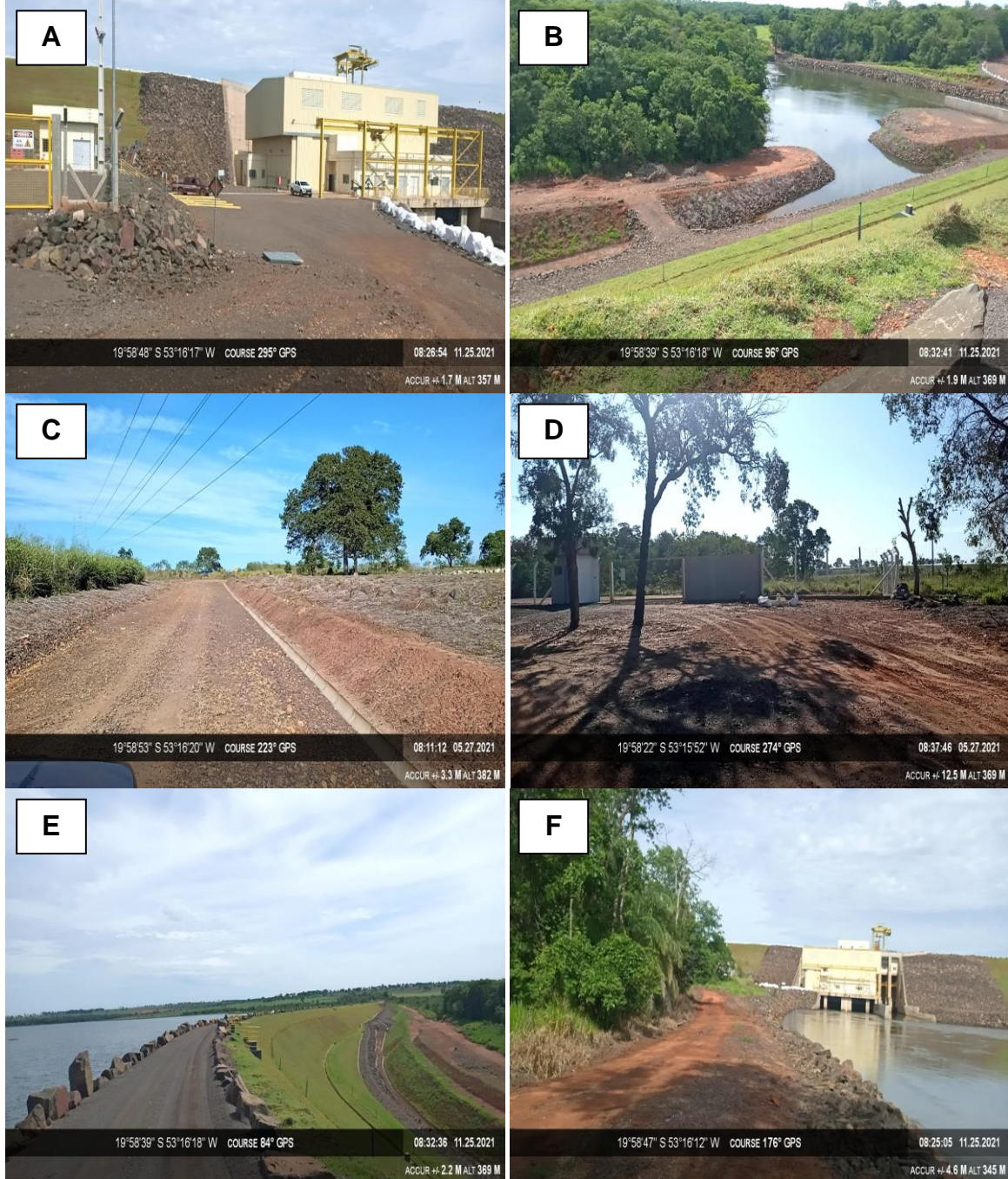
Figura 11 – Estradas de acesso interno da PCH Verde 4: (A) acesso a casa de força; (B) acesso a margem esquerda da jusante; (C) acesso ao barramento; (D) acesso a guarita e portão; (E) barramento; (F) acesso a jusante. Município de Água Clara/MS. Campanhas de 2021.
